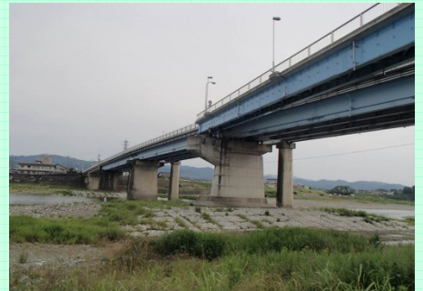
国道168号 大川橋
