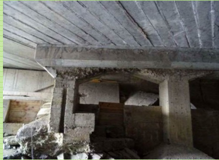
国道169号 新鷺本橋
